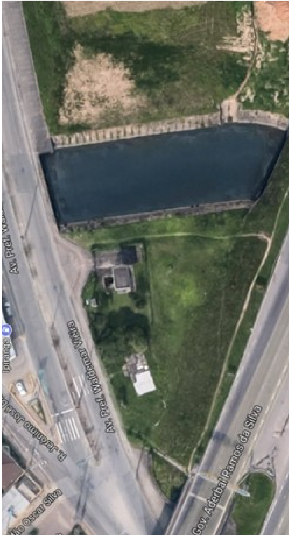
Figura 10: Vista aérea Estação Elevatória da CASAN
