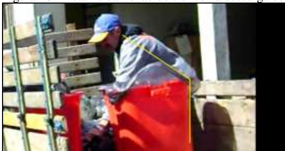
Figura 26 - Detalhe da flexão do tronco na descarga de resíduos
