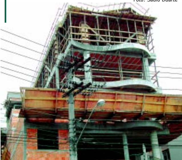
Prédio em construção no bairro Córrego Grande
