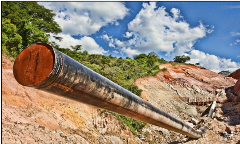
Figura 4. Mineroduto Minas-Rio em processo de instalação no município de Nova Era, Minas Gerais, 2014.
