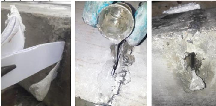
Figura 3.23 - Segunda aplicação do epóxi C na fenda de 20 mm (à esq.) e terceira aplicação do epóxi A (à dir.).
