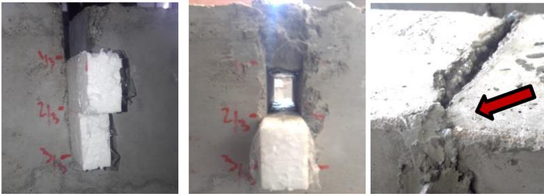
Figura 3.21 - Primeira aplicação do epóxi A (à esq.) e do epóxi B (à dir.).
