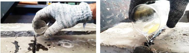
Figura 3.22 - Retirada da primeira camada de papel plastificado da fenda de 3 mm (à esq.). Segunda aplicação do epóxi A (centro) e fenda após a segunda aplicação (à dir.).
