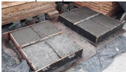
Ao total foram realizadas 5 betonadas para a moldagem dos 14 prismas de modo que para cada betonada foram moldados 3 corpos-de-prova. Durante as primeiras 48 horas após o lançamento e o adensamento do concreto, os prismas e os corpos-de-prova ficaram com suas formas sob uma lona plástica para se evitar a perda de água. Após isso, foi realizada a desforma dos moldes e aguardado o tempo de cura do concreto no laboratório sob temperatura de  $23^{\circ}\text{C} \pm 5^{\circ}\text{C}$ .
