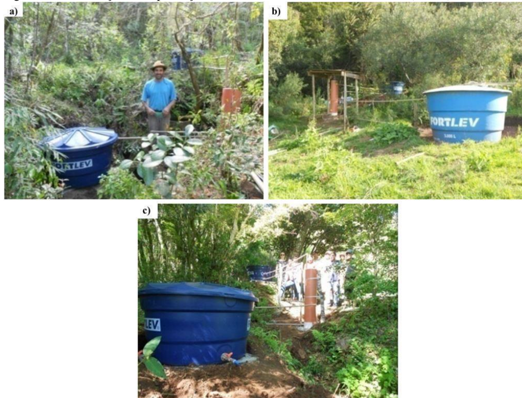
Figura 35 – Finalização da implantação dos Sistema com RRS, FLR e RF em a) L1; b) L2; c) L3.
