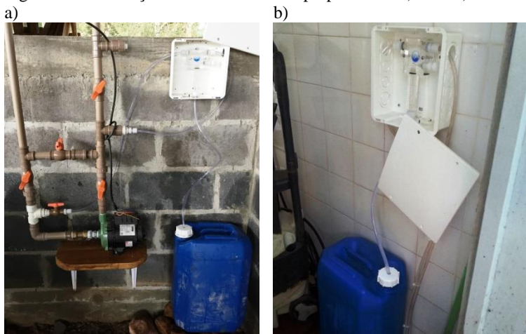
Figura 31 – Instalação dos cloradores nas propriedades a) L1 e b) L2.
