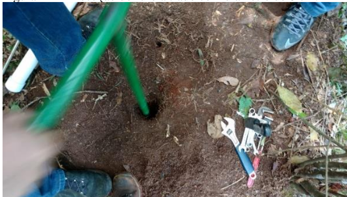
Figura 21 – Execução do furo a trado com diâmetro de 8 cm.
