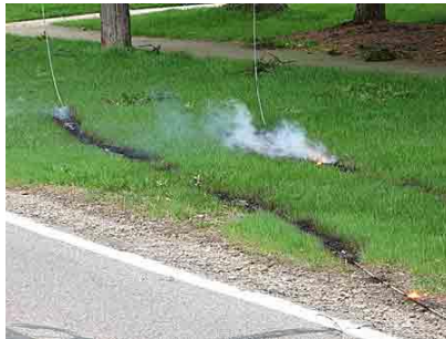
Figura 2 - Condutores rompidos energizados em contato direto a terra, porém de característica de alta impedância.
