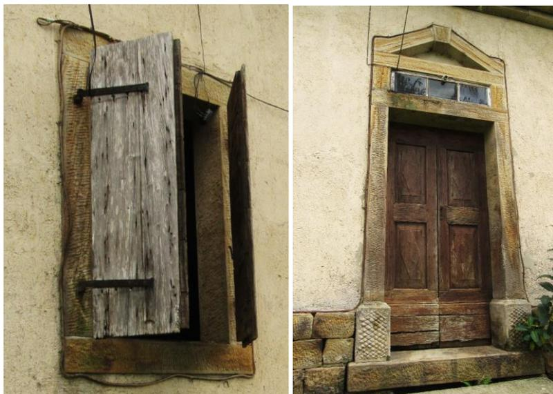
Figura 13 – Casa Cancellier – detalhes da cantaria da fundação, dos requadros da janela e da porta principal – Fonte: fotos do autor
