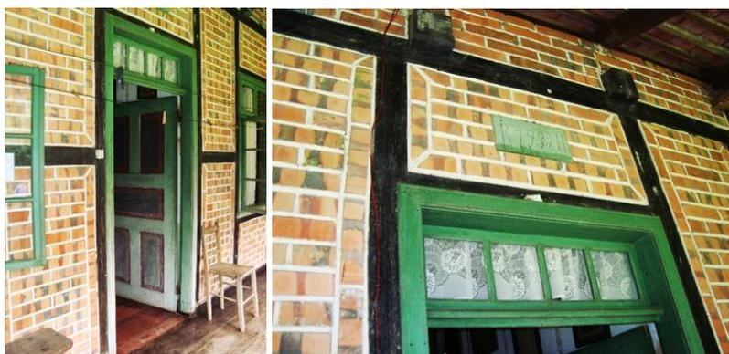
Figura 6 – Casa Hersing – detalhe da colocação dos tijolos na fachada principal
