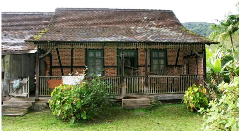
Figura 5 – Casa Hersing – fachada principal do módulo enxaimel
