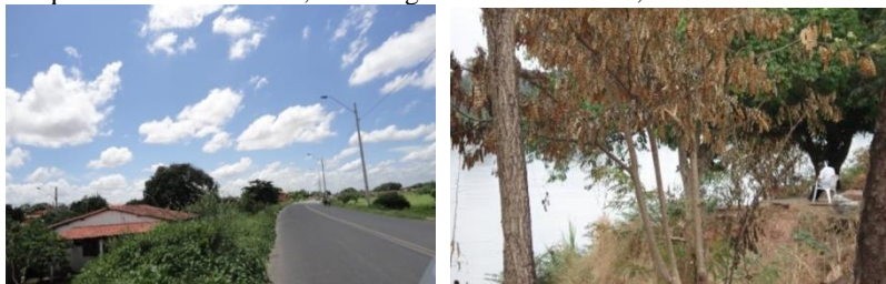
Figuras 52 e 53: Avenida Boa Esperança - dique de proteção da zona Norte. Parque Ambiental Prainha, nas margens do rio Parnaíba, Zona Sul
