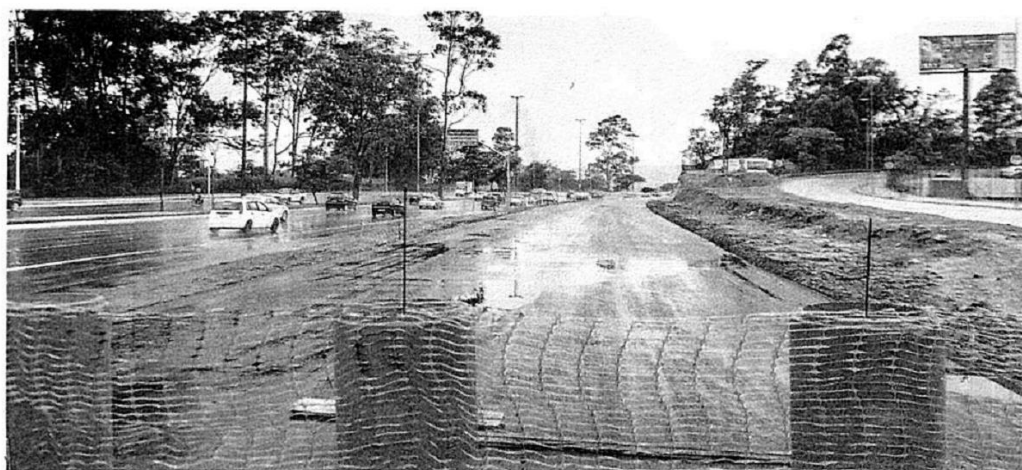
Agrônoma. Marginal da avenida Beira-Mar Norte está sendo pavimentada
