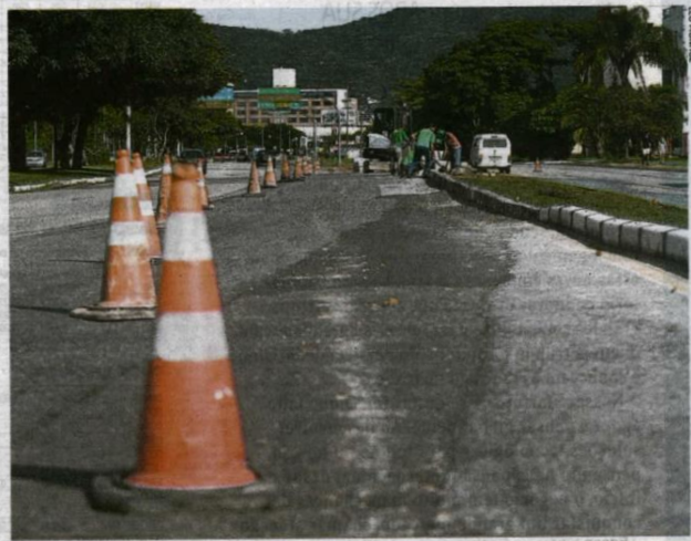
Ontem, funcionários já trabalhavam no trecho que teve obras interrompidas no ano passado
