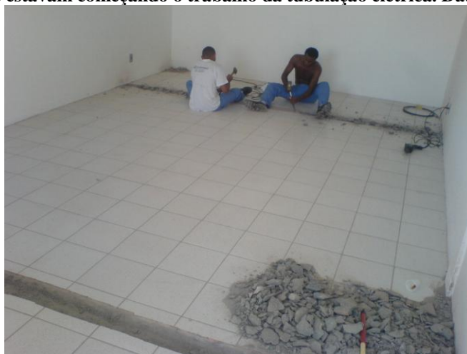
Figura 13- Sala de novos talentos, onde o laboratório de informática será instalado. Neste momento, dois técnicos estavam começando o trabalho da tubulação elétrica. Data: 04/08/2008
