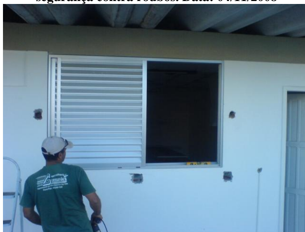
Figura 18 - Colocação de grades na sala de Novos Talentos, proporcionando assim o aumento da segurança contra roubos. Data: 04/11/2008
