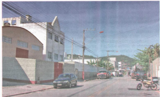
Rua Célio Veiga, parte da antiga Vila Palmira, em Barreiros (São José). Onde está a edificação maior, à esquerda, funcionava a casa de Maria Barbosa
