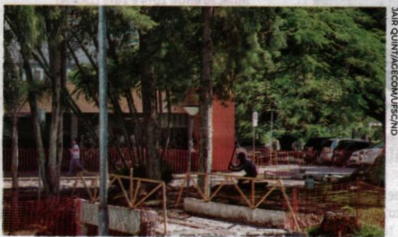
Obras em andamento próximo ao prédio da Reitoria da UFSC
