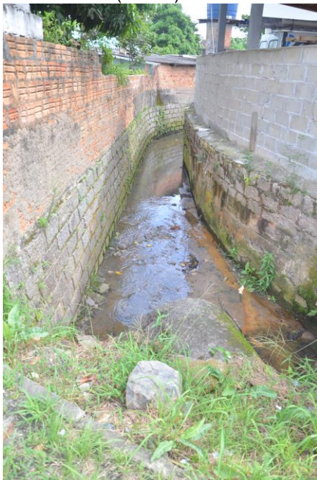
Figura 67: O fechamento completo em uma margem na Bacia do Itacorubi (acima) e a abundância de aberturas em outra situação na mesma Bacia (abaixo).
