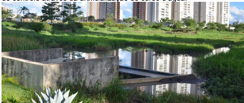
Figura 13: Assoreamento da nascente do córrego Cascavel, em Goiânia, o desmoronamento de suas margens, enchentes e a tentativa de controle através da artificialização do curso d'água.
