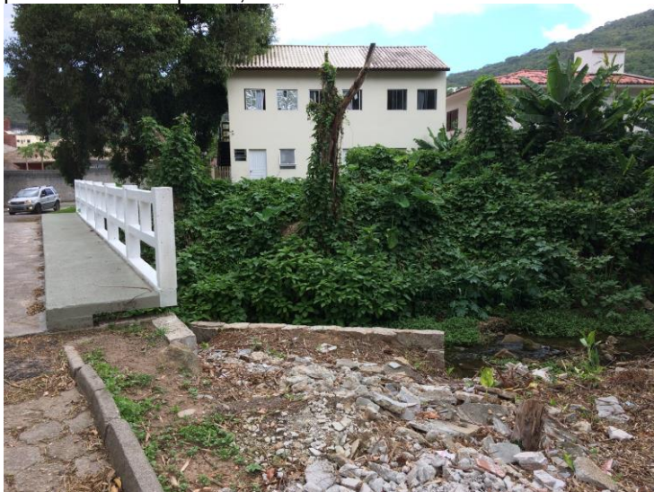
Figura 71: Margens preservadas, ao mesmo tempo que são parcialmente ocupadas, na Bacia do Itacorubi.
