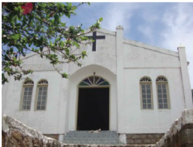
Figura 35: Igreja – Ponto 16. Fonte: Acervo próprio (2016).
