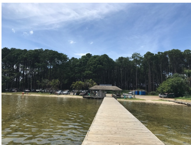
Figura 44: Visita trapiche e edificação. Fonte: Acervo próprio (2016).
