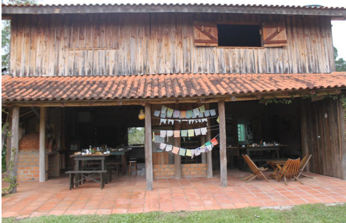
Figura 1: Sítio Capororoca: Edificação onde se encontram agroindústria, área de recepção de turistas e dormitórios.
