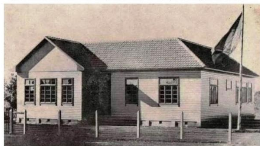
Construções escolares no Rio Grande do Sul — Tipo para zona rural, em madeira, para 150 alunos; de 1939 a 1944, foram construídos vinte e nove deste tipo
