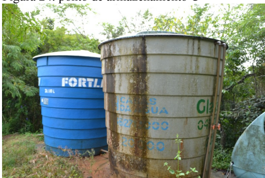
Figura 24: ponto de armazenamento C
