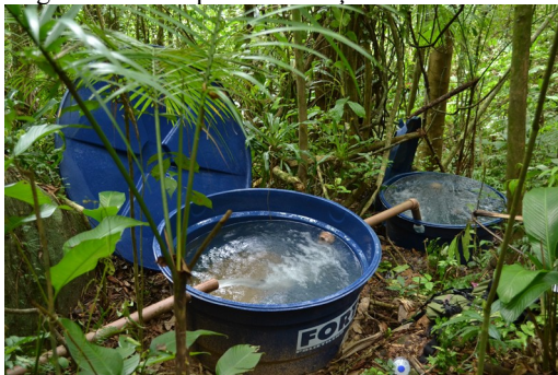
Figura 21: ponto de captação F (Vista 2). Caixas d'água utilizadas para decantação de sedimentos.
