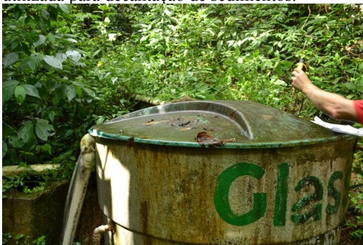
Figura 17: ponto de captação C. Caixa d'água utilizada para decantação de sedimentos.
