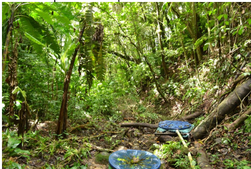
Figura 15: ponto de captação A2. Caixas d'água utilizadas para decantação de sedimentos.
