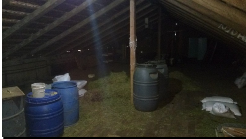
FIGURA 23 - Segundo piso do galpão.
