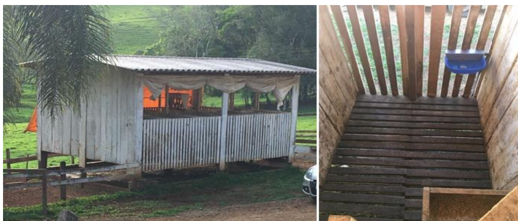
Figura 6: Bezerreiras de madeira, acima do nível do solo, cobertas, com baias individuais e piso ripado.
