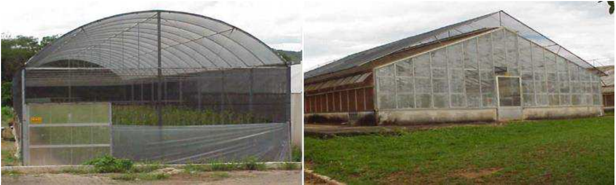
Figura 4 – Estufas em formato de arco e formato capela, respectivamente. (Adaptado de REIS, 2005).
