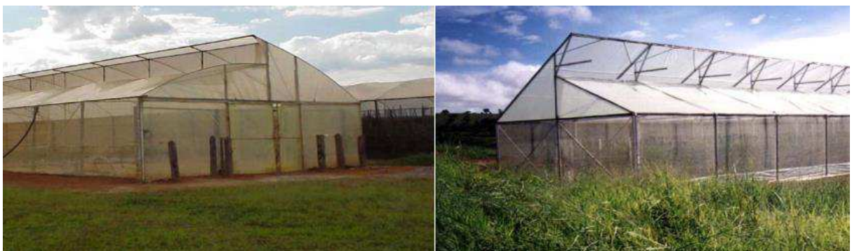
Figura 3 – Tipos de estruturas com teto convectivo em formato curvilíneo e retilíneo, respectivamente.
