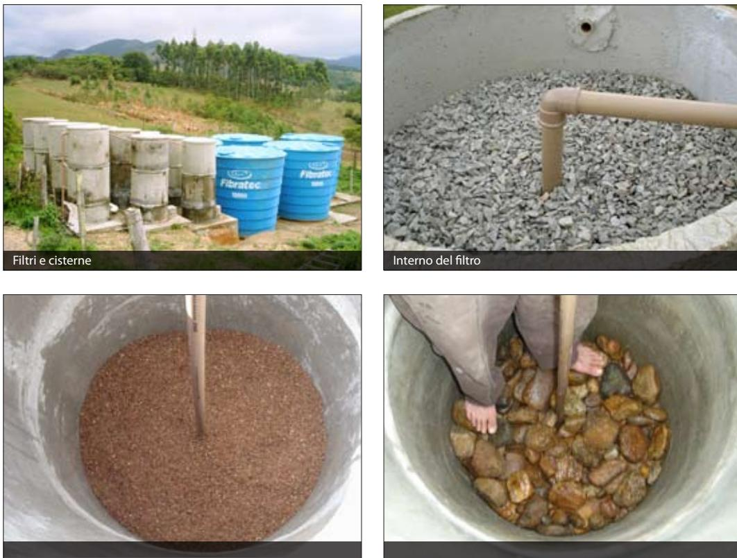
Fig. 10. Sistema di depurazione dell'acqua a letto filtrante di sabbia e ghiaia
