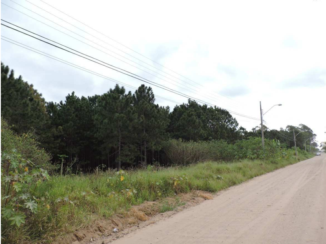
Figura 11 - Entrada Norte - Descaso com as calçadas
