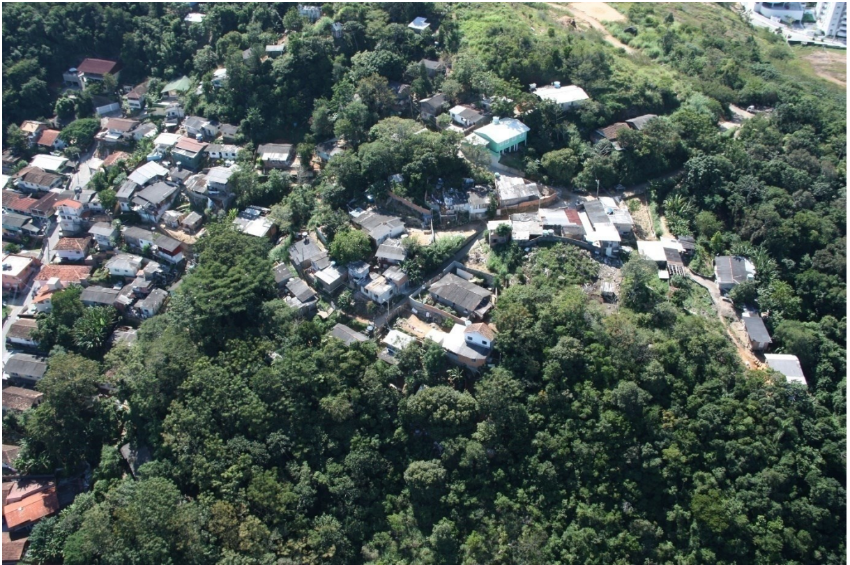
Figura I Fotografia aérea da Comunidade Boa Vista
