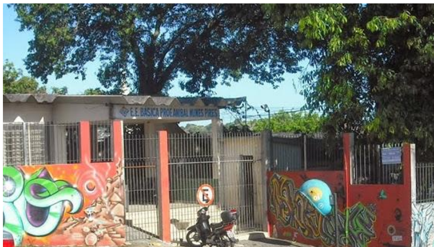
Figura 4.6. Portão de acesso à EEB Prof. Aníbal Nunes Pires.
