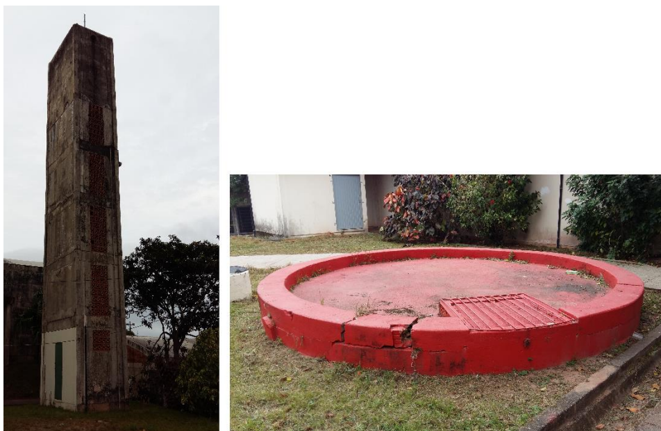
Figura 4.11. Castelo d'água e reservatório inferior da EEB Prof. Aníbal Nunes Pires.
