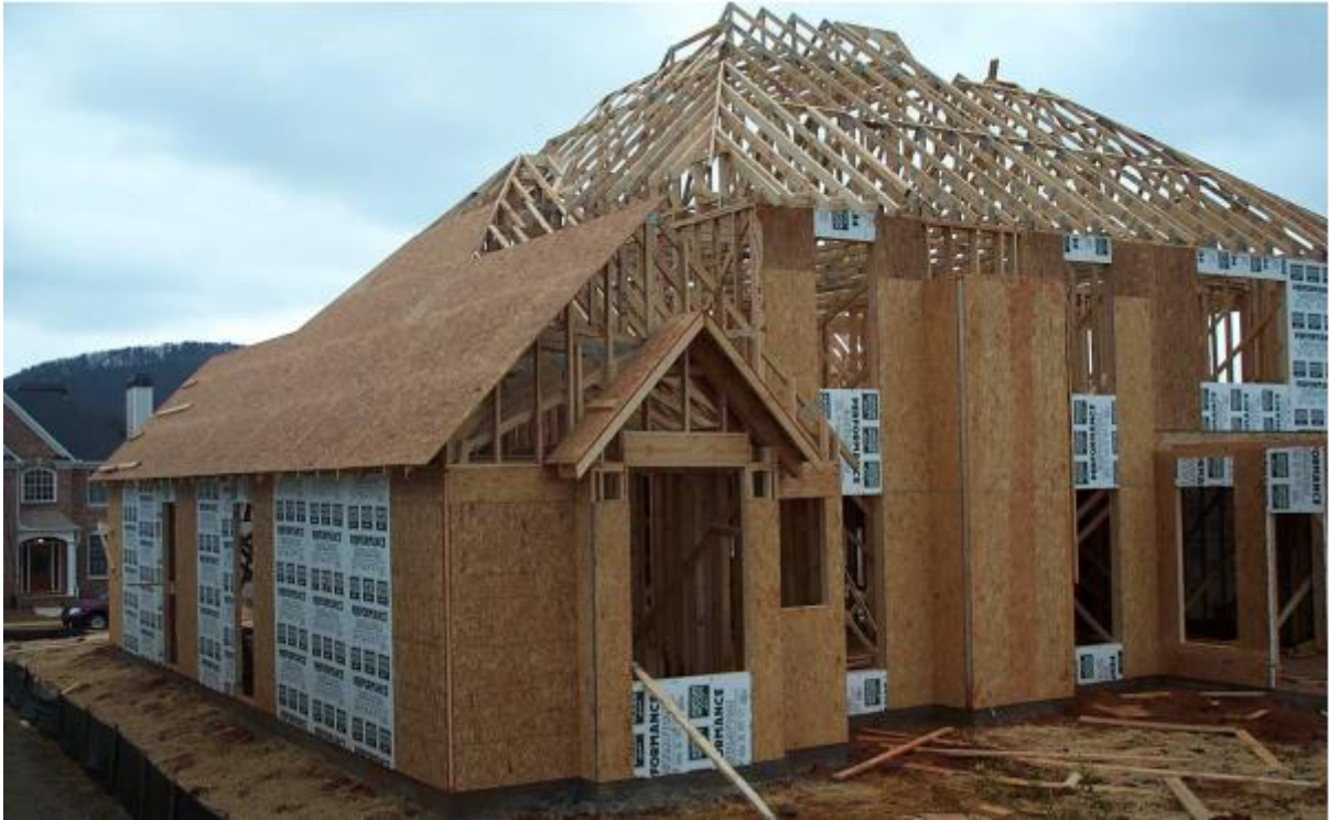
Figura 9: Construção de residência com o sistema de Wood Frame
