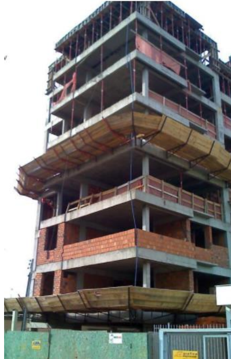
Figura 5: Alvenaria sendo levantada sobre a estrutura em concreto armado
