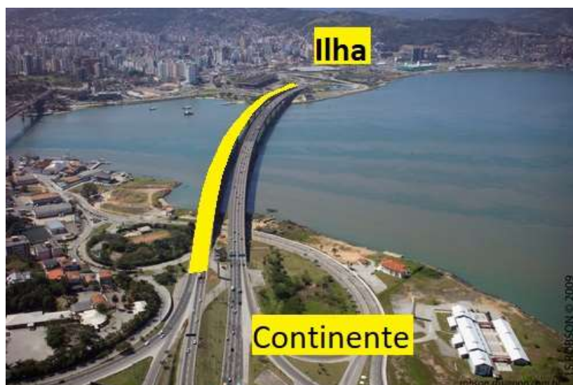
Figura 47 – Ponte Colombo Salles
