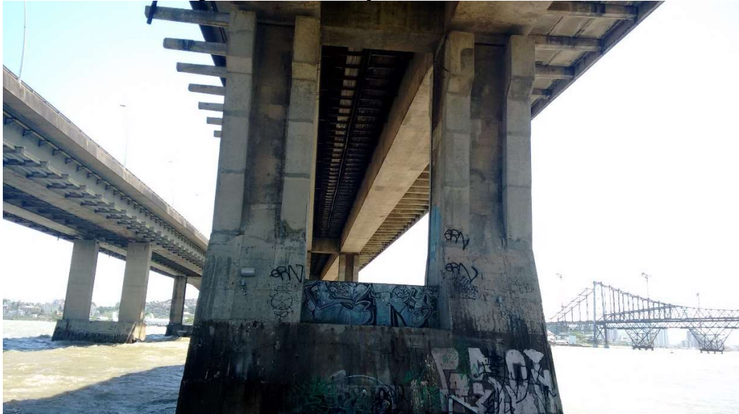
Figura 48 – Localização das fissuras
