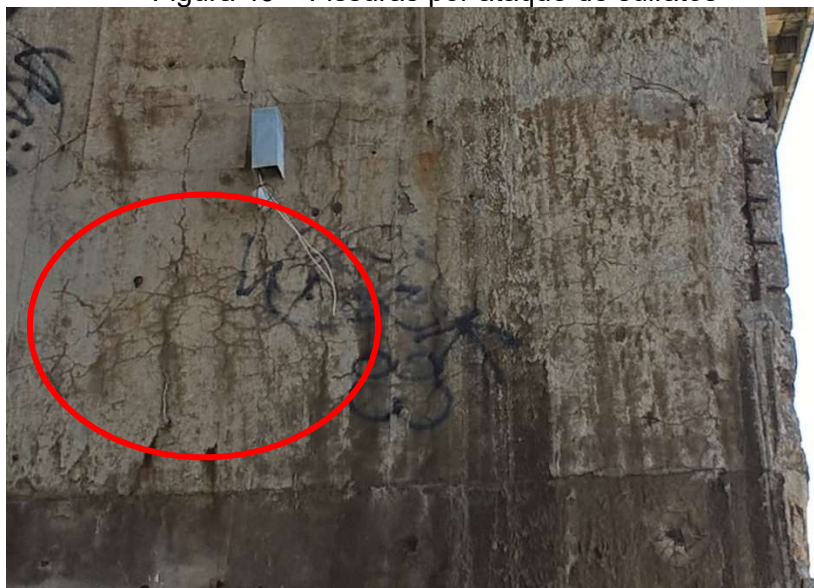
Figura 49 – Fissuras por ataque de sulfatos
