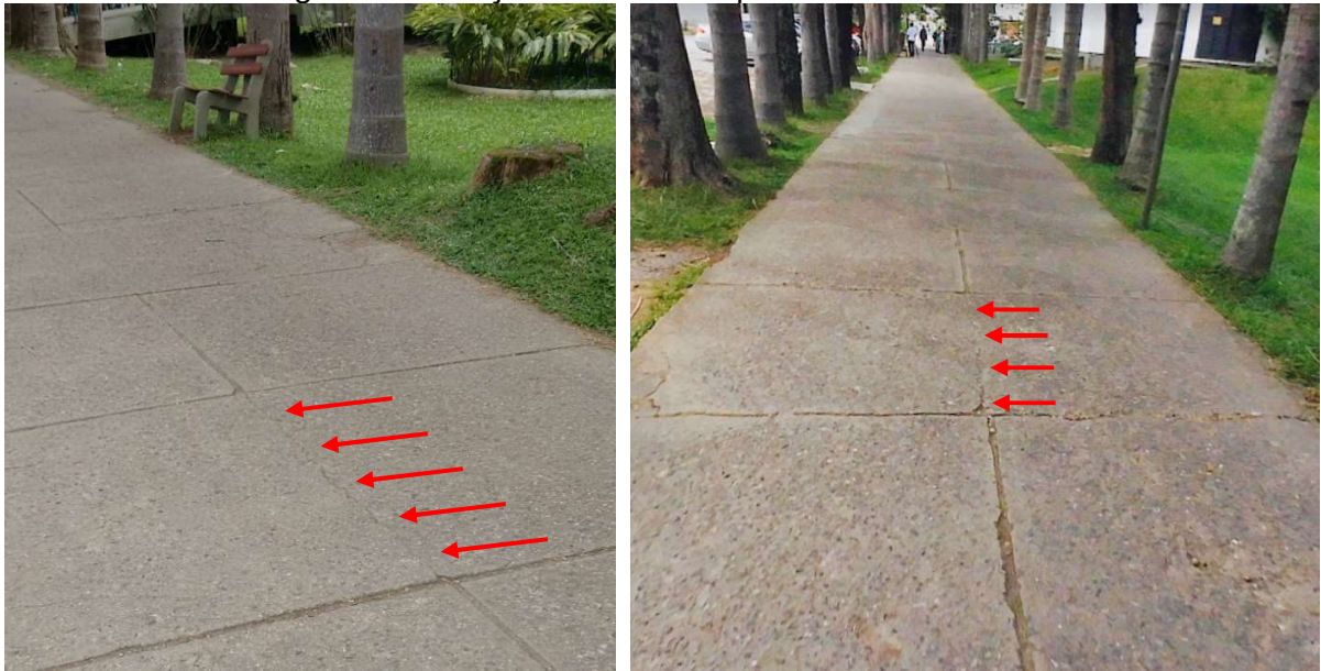
Figura 36 – Calçada onde estão presentes as fissuras
