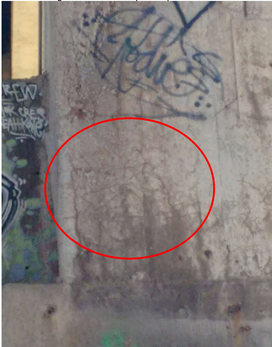
Figura 50 – Fissuras por ataque de sulfatos
