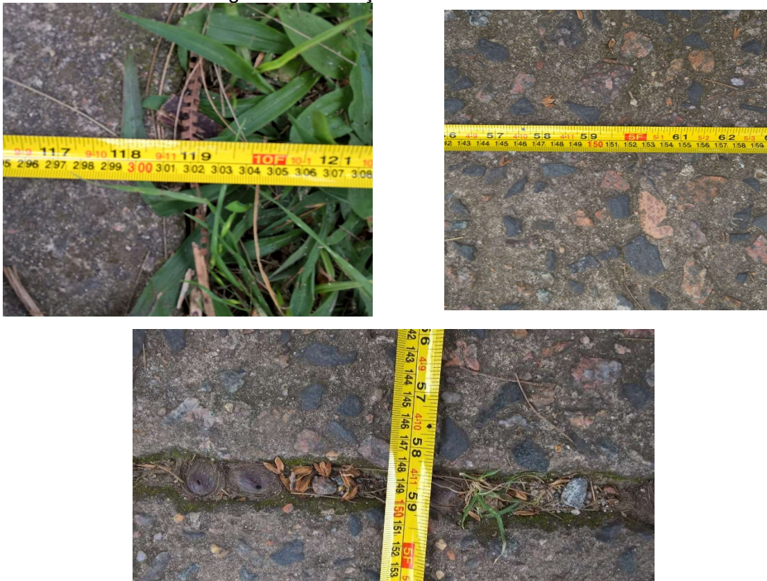
Figura 38 – Medições relativas à fissura.
