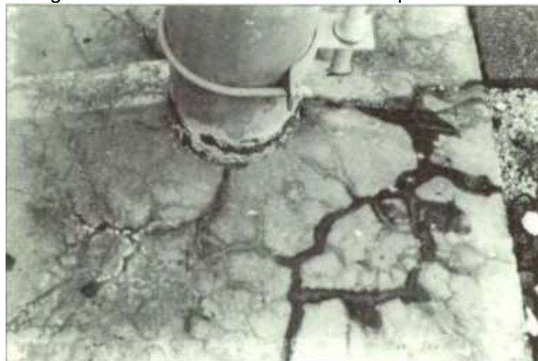
Figura 15 - Fissuras decorrentes de ataque de sulfato
