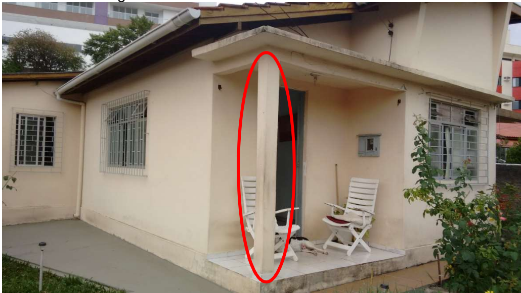
Figura 32 – Casa onde está localizada a fissura
