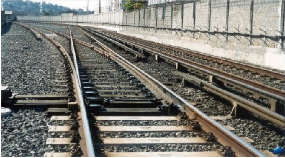
Figura 23 - Aparelho de Mudança de Via
