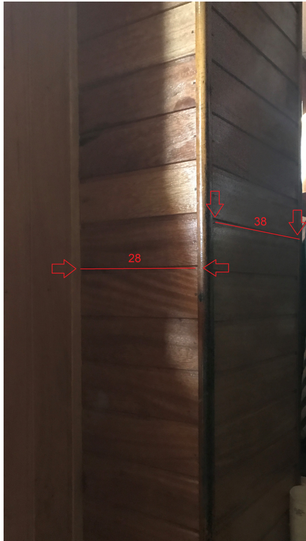
Figura 36 - Área externa da tubulação de entrada de ar
