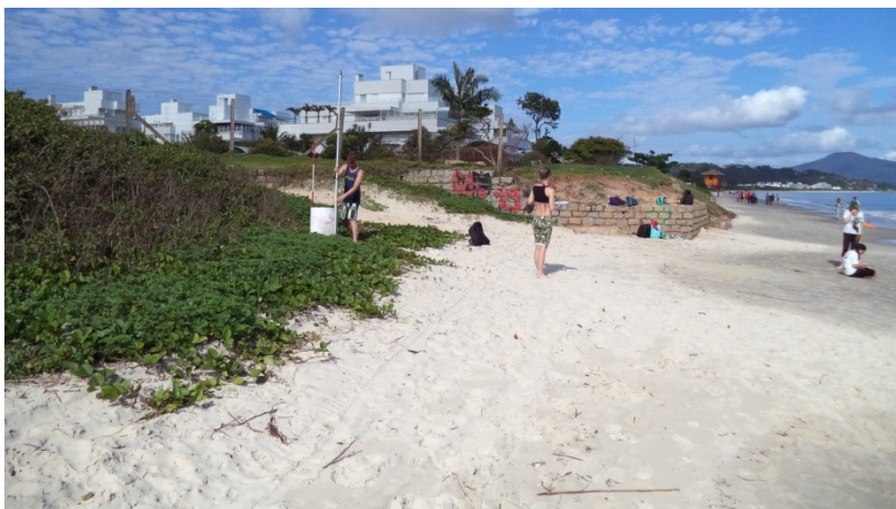
Figura 61. Presença de estrutura rígida (muro) e aterro sobre as dunas frontais no perfil 4, em Jurerê (Foto de Noberto Olmiro Horn Filho, novembro 2015).
