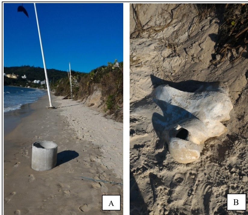
Figura 53. Erosão acentuada na praia de Jurerê. A. Recuo das dunas frontais e B. Aparecimento de ossada de baleia devido à erosão costeira (Fotos de Mayara Moreira da Silva, junho de 2017).
