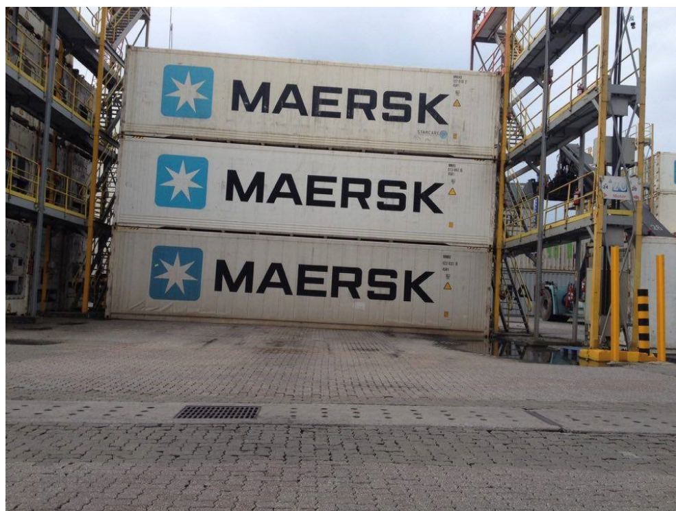
Figura 29: Adensamento do pavimento intertravado devido a carga dos contêineres.
