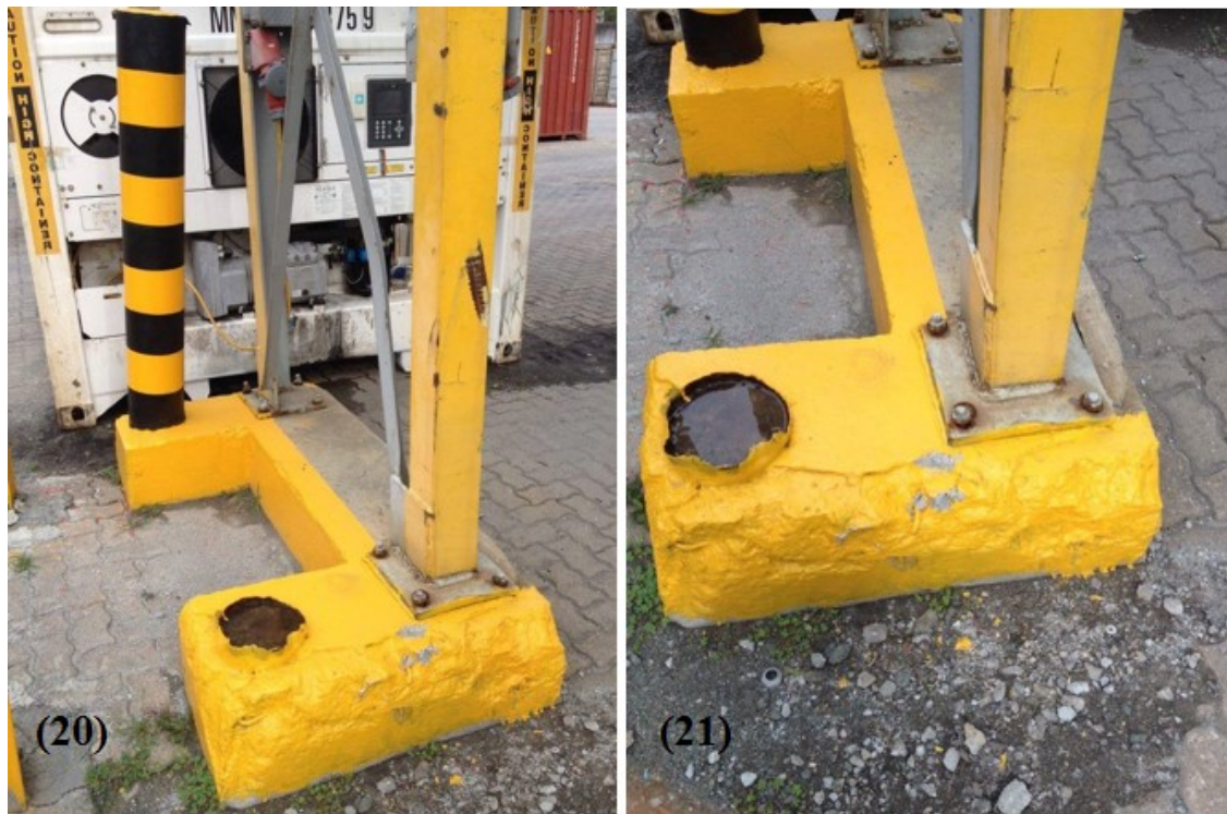
Figura 27: Choque mecânico na estrutura dos reefers (20); Corrosão na estrutura metálica dos reefers (21).
