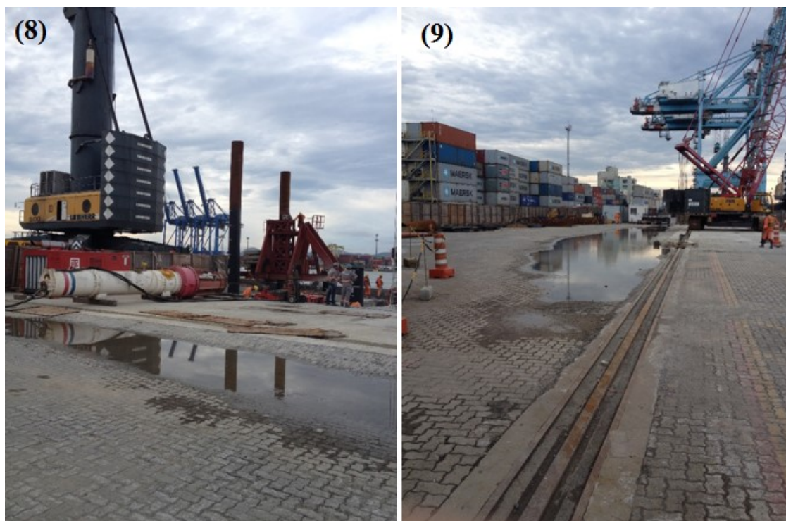
Figura 21: Acúmulo de água no berço 1 (8); Estado do trilho utilizado para translação dos portêineres (9).
