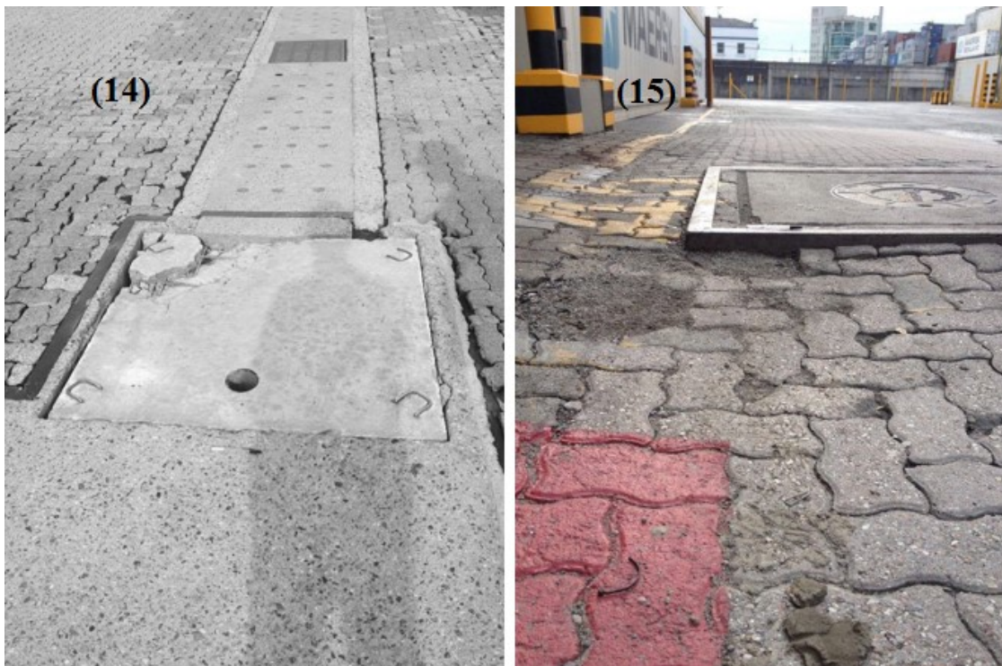
Figura 24: Rachadura na tampa de concreto (14); Adensamento do pavimento intertravado (15).
