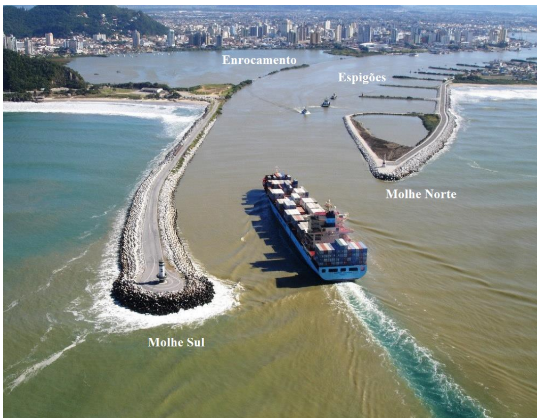
Figura 18: Obras de abrigo (vista aérea).
