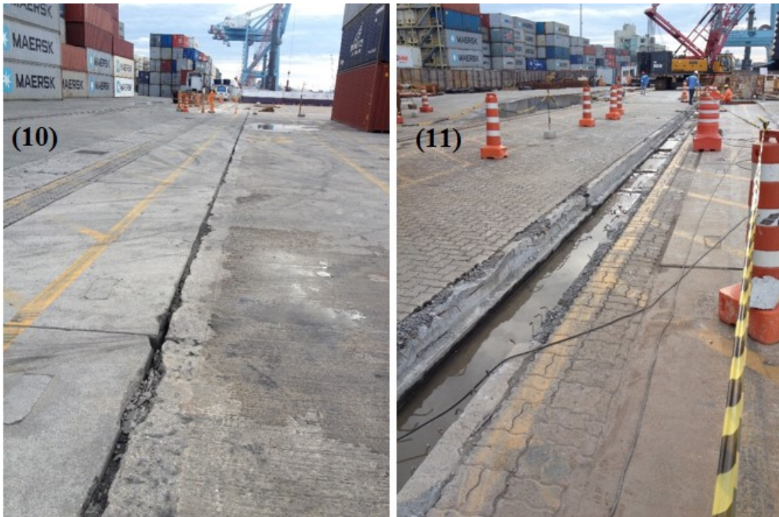
Figura 22: Degradação na junta de dilatação e desgaste no pavimento de concreto (10); Reparo na valeta de escoamento (11).
