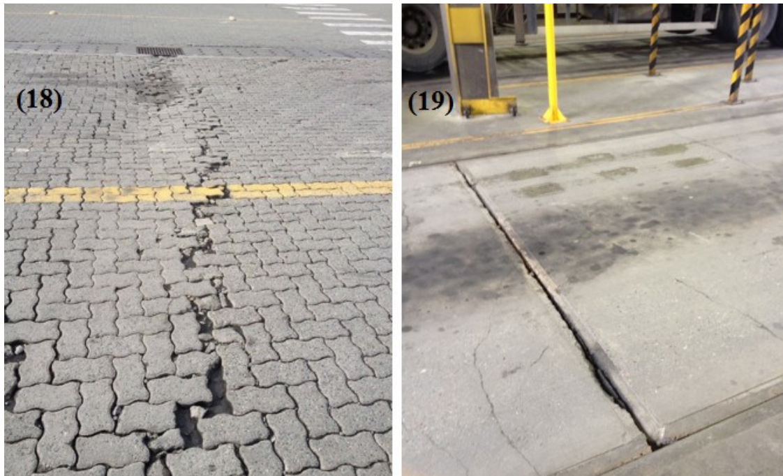
Figura 26: Fissura transversal pavimento intertravado (18); Fissura transversal pavimento rígido de concreto (19)
