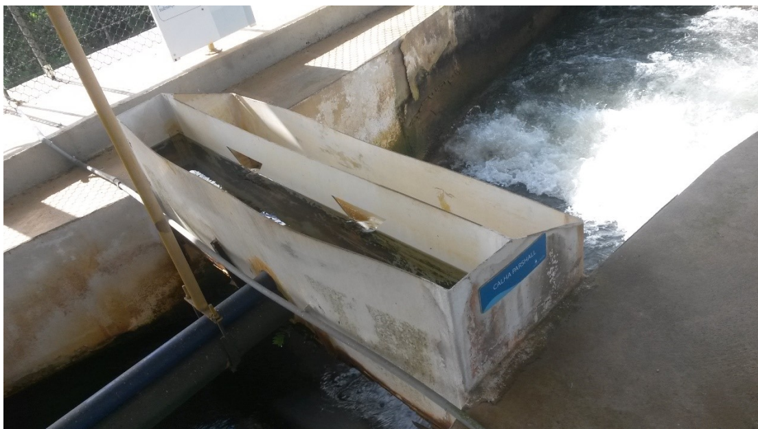
Figura 6 – Calha Parshall com unidade de mistura rápida
