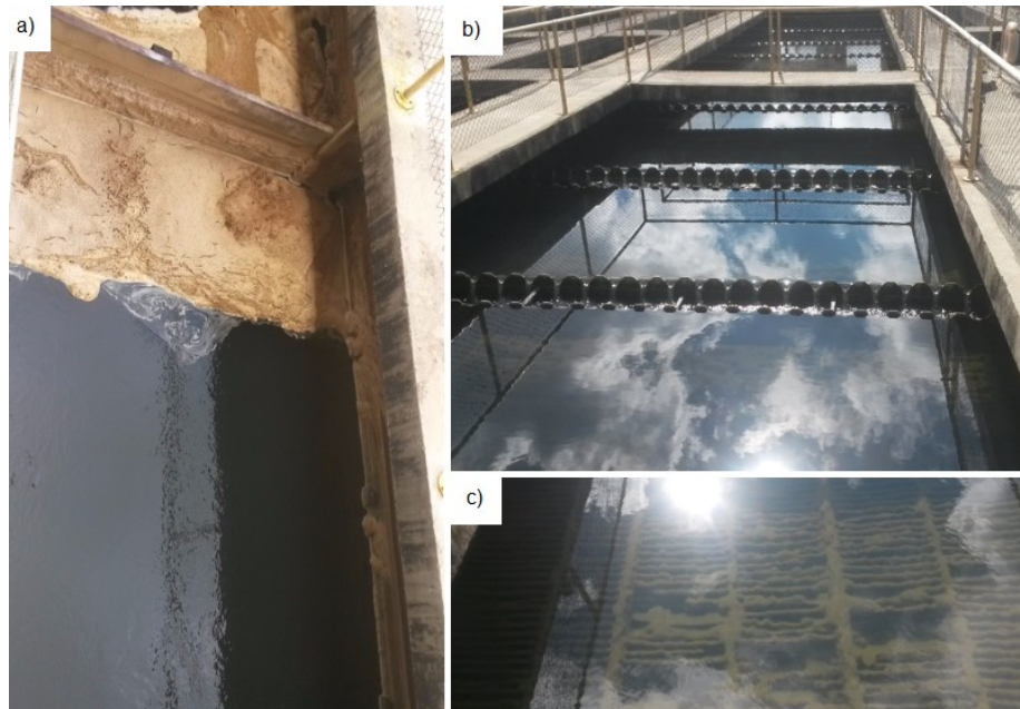
Figura 7 – a) Floculador hidráulico com chicanas de madeira b) Decantadores de alta taxa com placas de PVC c) Flocos acumulados no fundo
