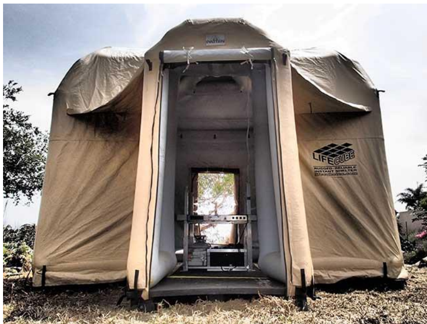
Figura 8 – Estrutura pneumática Life Cube.
