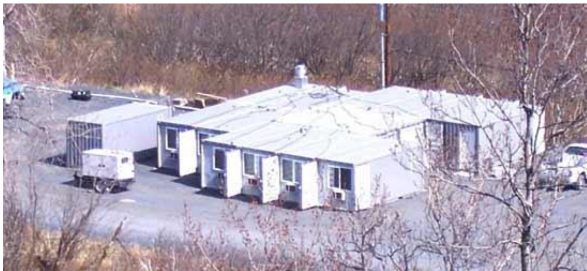
Figura 4 – Combinação de abrigos modulares.
