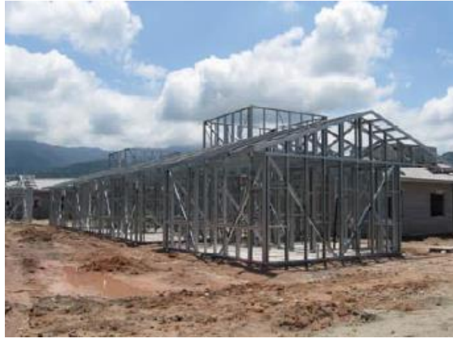
Figura 2 – Visão geral da estrutura de uma residência em LSF.
