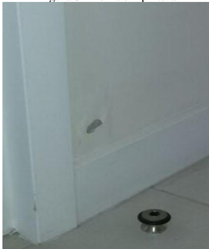
Figura 8 - Bolha em pintura
