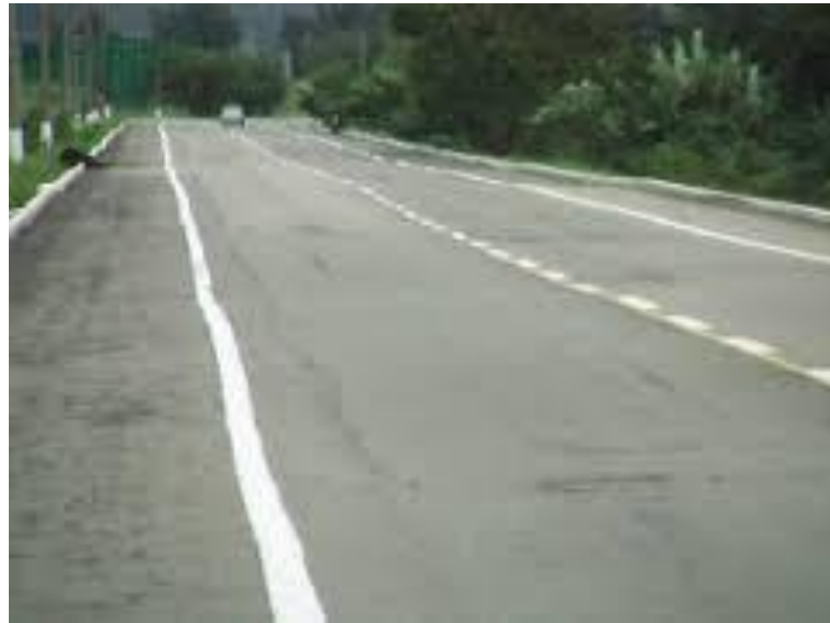
Figura 12 – Irregularidade Longitudinal
