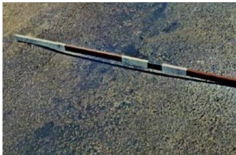
Figura 09 – Afundamento Plástico
