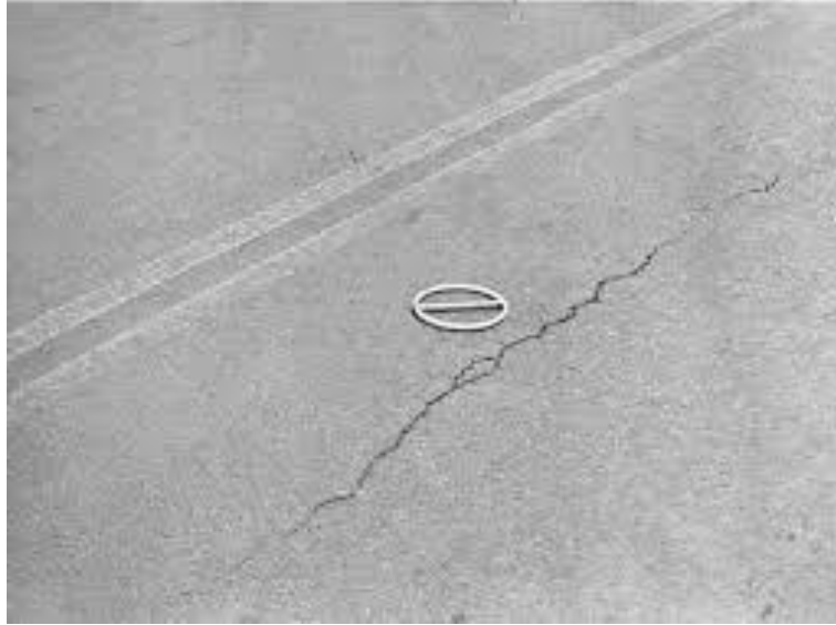
Figura 06 – Trinca Longitudinal
