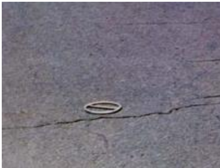
Figura 05 – Trinca Transversal
