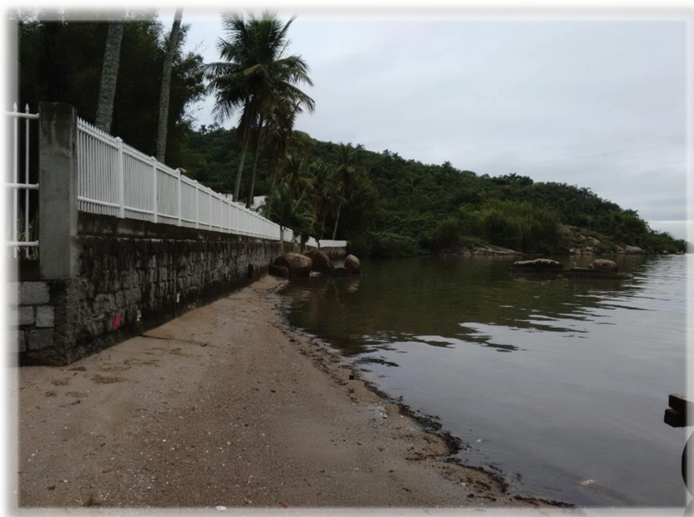
Imagem 12 – Muro que impede a passagem à APP – Ponta do Goulart.
