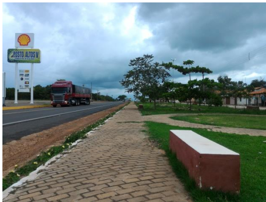
Figura 21 – Ocupação efetiva de Faixa de Domínio na BR-343/PI.
