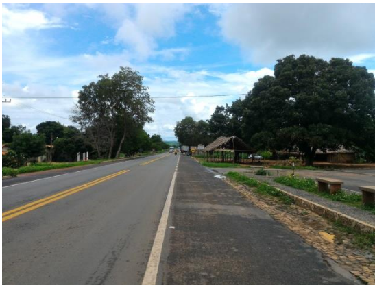
Figura 17 – Ocupação de espaços vazios na Faixa de Domínio na BR-343/PI.
