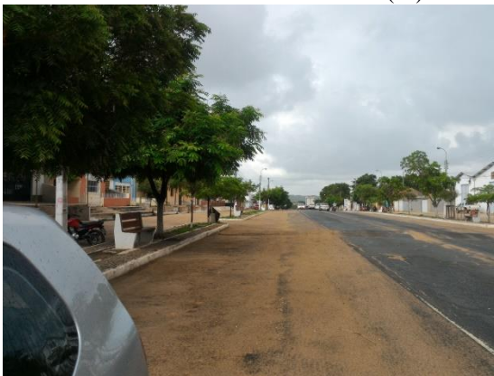
Figura 19 – Vias laterais na Faixa de Domínio na BR-343/PI em Demerval Lobão (PI).
