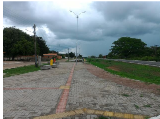
Figura 22 – Ocupação efetiva de Faixa de Domínio na BR-343/PI.
