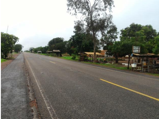
Figura 3 – Ocupação irregular de Faixa de Domínio na BR-316/PI.
