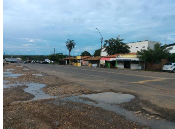
Figura 4 – Ocupação irregular de Faixa de Domínio na BR-343/PI.
