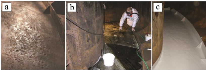
Figura 2.9 – Aplicação de revestimento de compósito em tanques de lastro de um navio plataforma tipo FPSO. (a) Piso com corrosão; (b) Processo de aplicação do compósito; (c) Piso reparado. Adaptado de [17].
