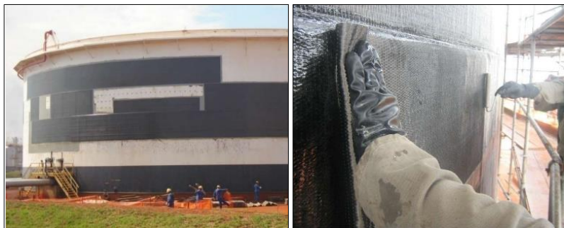
Figura 2.7 – Aplicação de revestimento de compósito no exterior de tanques de armazenamento de combustível [21].
