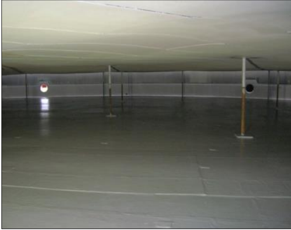
Figura 2.8 – Aplicação de revestimento de compósito no interior de tanques de armazenamento de combustível [21].
