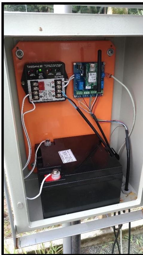
Figura 8 - Sistema instalado em campo
