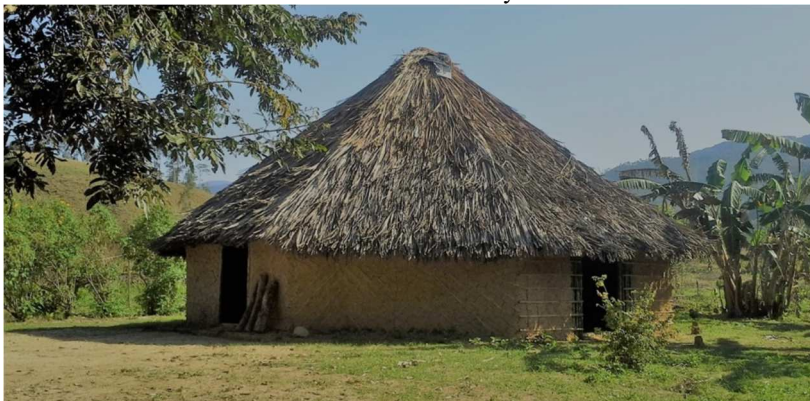
Figura 17 - Oo jere construída para sediar o IV Grande Encontro Guarani da ASIE-SC no Tekoa Vy'a.
