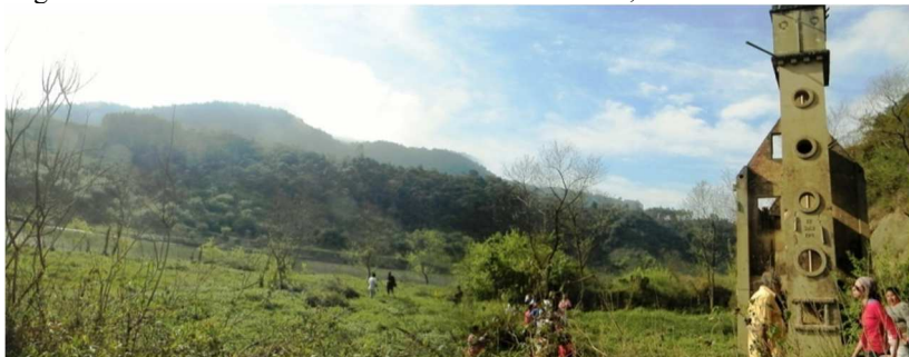
Figura 13 – Ruínas do escritório de Eduardo Hoerhann, à beira do Rio Hercílio.
