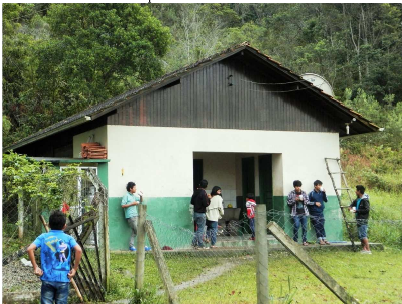
Figura 6 - Escola do Tekoa Yvyã Yvate, aldeia de Laranjeiras/Morro Alto, no município de São Francisco do Sul.
