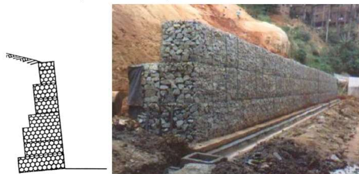
Figura 3 - Muro de gravidade construído com gabões. Fonte: GERSCOVICH ET AL (2016).
