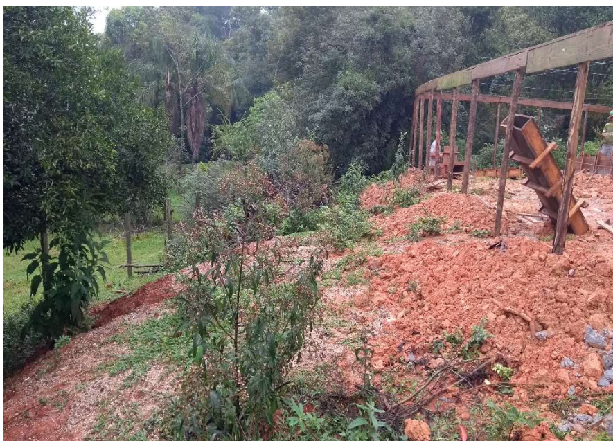
Figura 22 - Fundos do terreno onde será construído o muro de contenção. Fonte: arquivo próprio.
