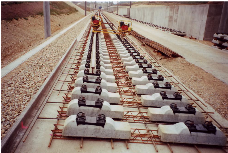
Figura 46 – Ferrovia em laje de concreto armado
