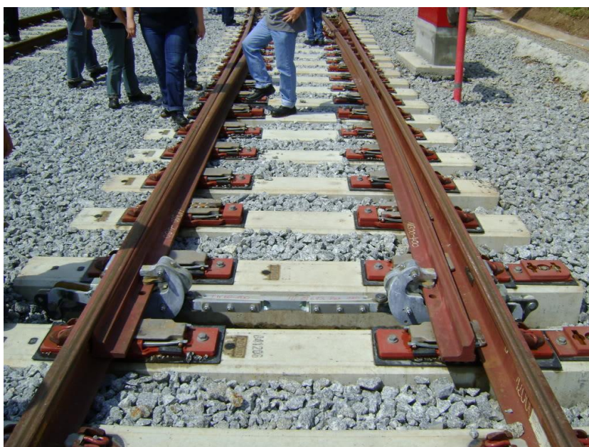
Figura 36 - Dormente em concreto
