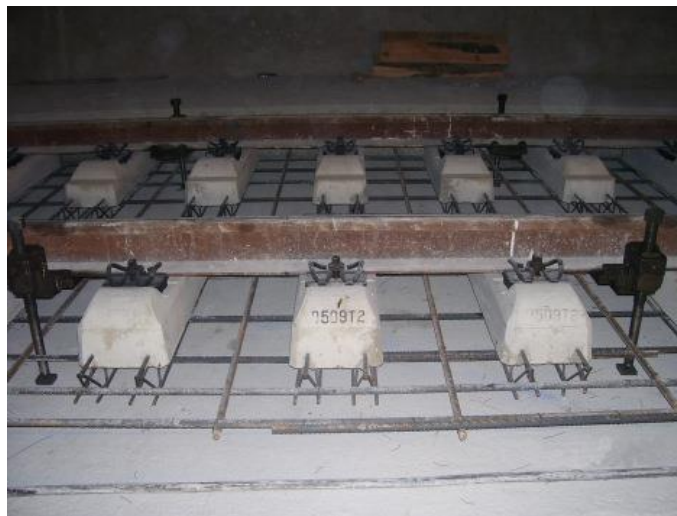
Figura 48 – Dormente de concreto bi-bloco sobre superestrutura em laje
