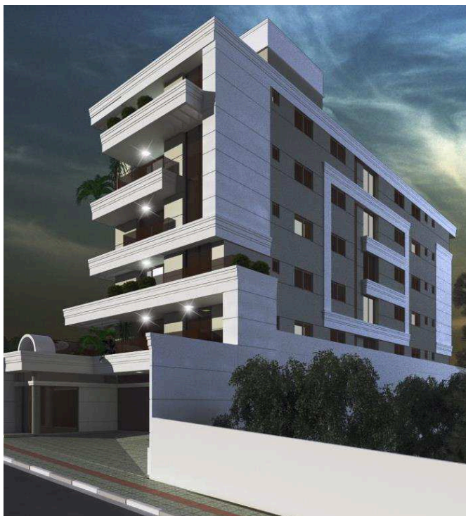
Figura 2 - Fachada da edificação
