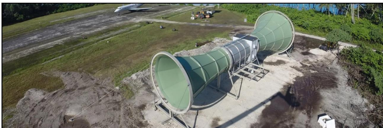
Figura 38 – Instalação do sistema INVELOX na Ilha de Palmyra, ao sul do Havaí.
