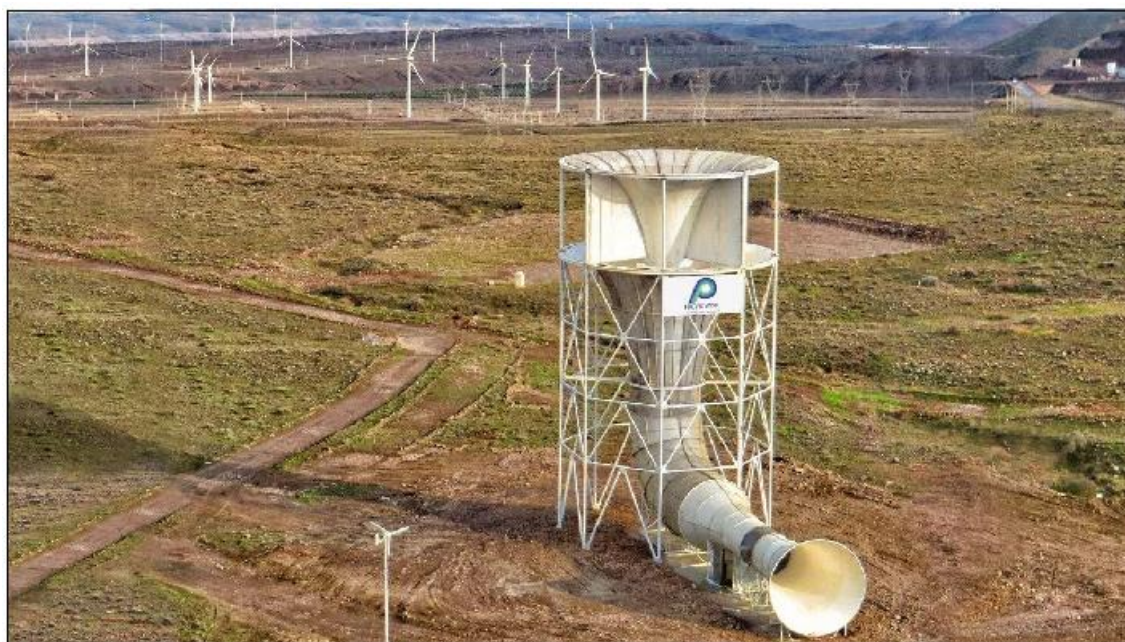
Figura 32 – 100KW de geração de energia na Nova Zelândia através do sistema INVELOX
