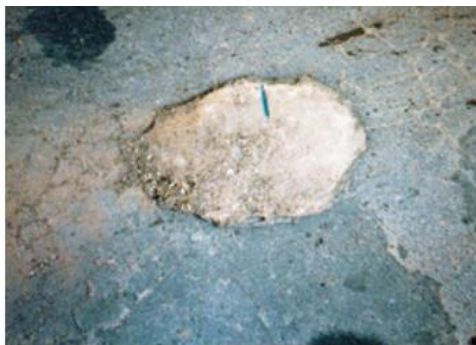
Figura 8 - Buraco Tipo Panela no Pavimento
