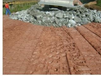
(b) Camada de Pedra Detonada
