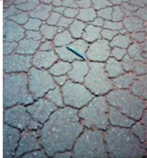
Figura 7 - Trincas Couro de Jacaré
