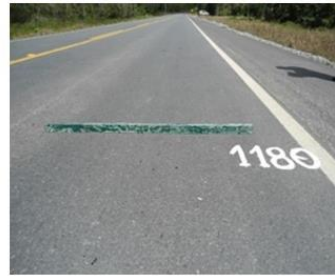
(d) Revestimento Asfáltico
