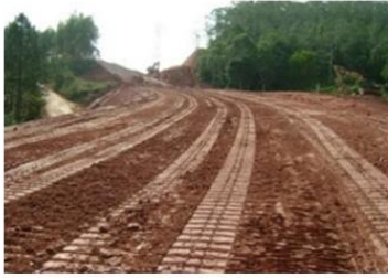
(a) Camada Final de Terraplenagem
