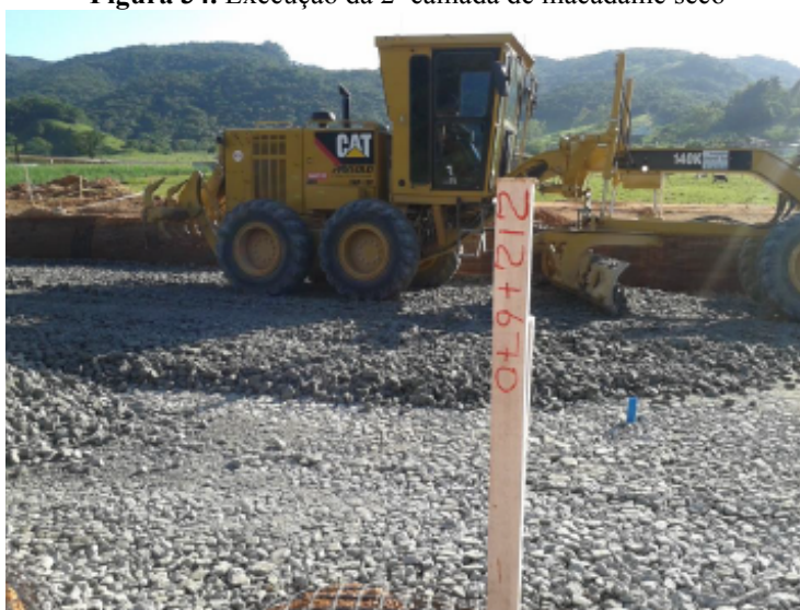
Figura 34. Execução da 2ª camada de macadame seco
