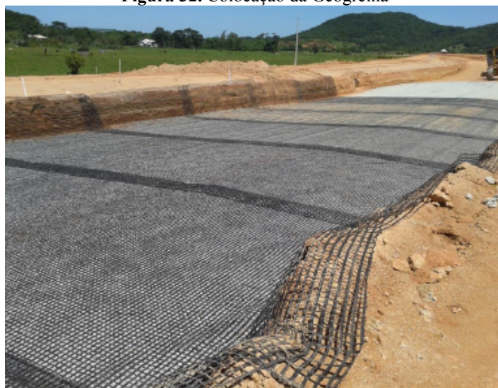
Figura 32. Colocação da Geogrelha
