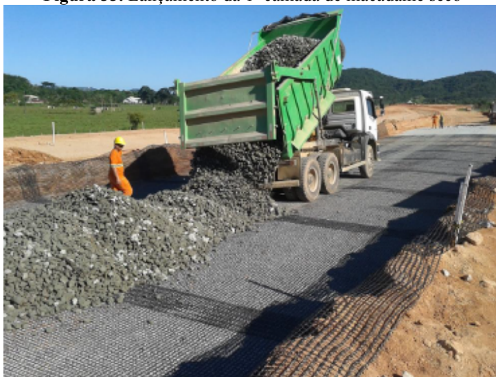
Figura 33. Lançamento da 1ª camada de macadame seco
