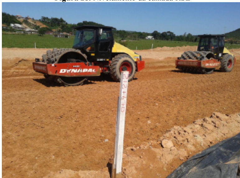
Figura 28. Nivelamento da camada RSL
