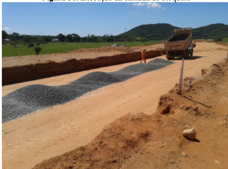
Figura 31. Execução da camada de bloqueio
