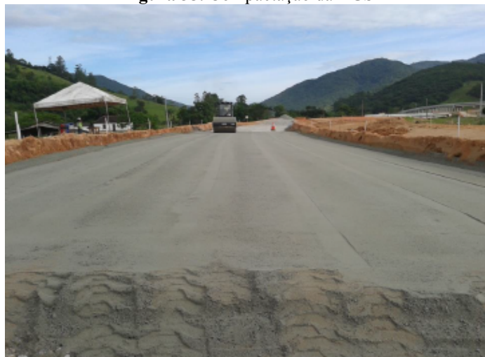
Figura 35. Compactação da BGS
