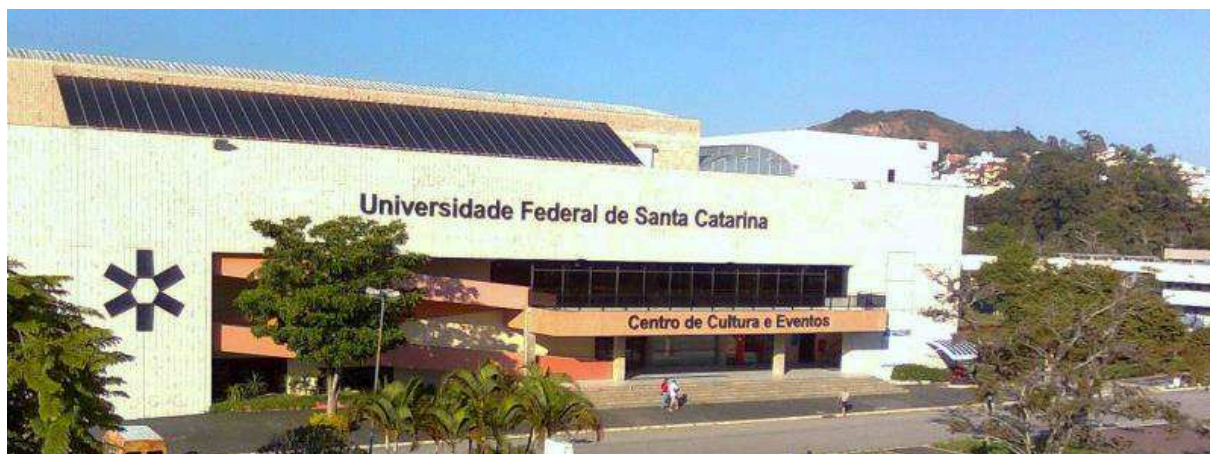
Figura 3.14- Módulos FV na cobertura e fachada frontal do Centro de Cultura e Eventos da UFSC (FOTOVOLTAICA-UFSC, 2017).
